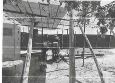
**Foto N° 02:** En la imagen se aprecia al personal de la meta 39 en el Pozo IRHS-11-01-08-1417, equipado, estado Utilizado, motor eléctrico y bomba turbina vertical.
