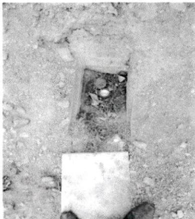
EL POZO TIENE INSTALADO SU EQUIPO DE MEDICION DE CAUDAL DE MARCA ZENNER, CON SERIE N° 9806235, ARROJANDO UN CONSUMO DE 38 080 M3 AL MOMENTO DE LA VERIFICACION TECNICA DE CAMPO.
