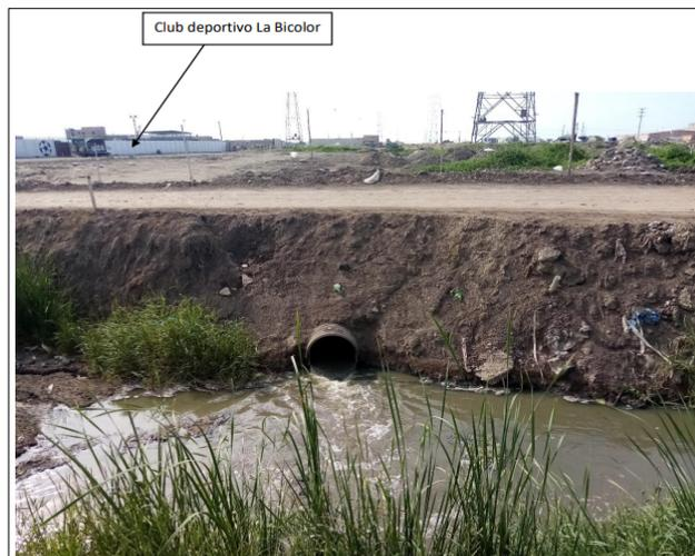
**Imagen 2:** Tubería de plástico corrugado de aproximadamente 20" de diámetro en el dren 3100, al Este de la Av. Panamericana Norte, coordenadas referenciales UTM WGS84 zona datum 17M: 0625768 E – 9248604 N, distrito de Chiclayo, provincia de Chiclayo, departamento de Lambayeque. Fecha 12.02.2024
