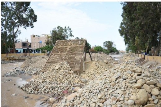
Foto N°01: Zaranda en margen derecha del río Tierras Blancas.
