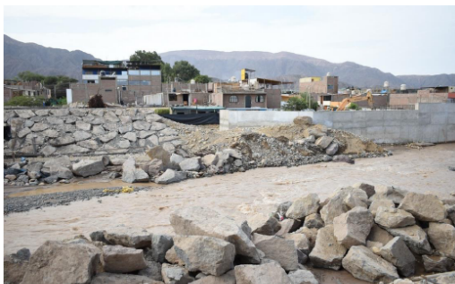
Foto N°03: Dique enrocado en proceso de remodelación.
